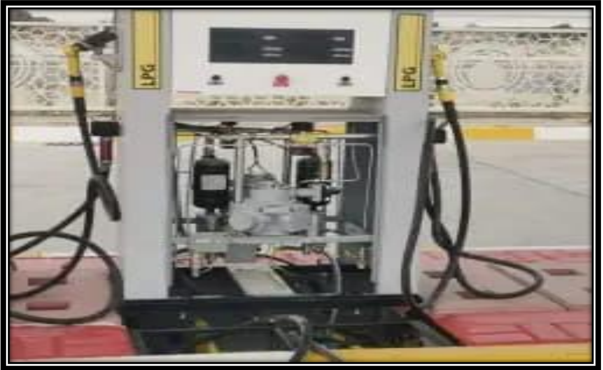
الصورة(2) انابيب الغاز في محطة تعبئة غاز السيارات
