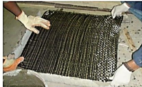
(d) First layer of fabric application
